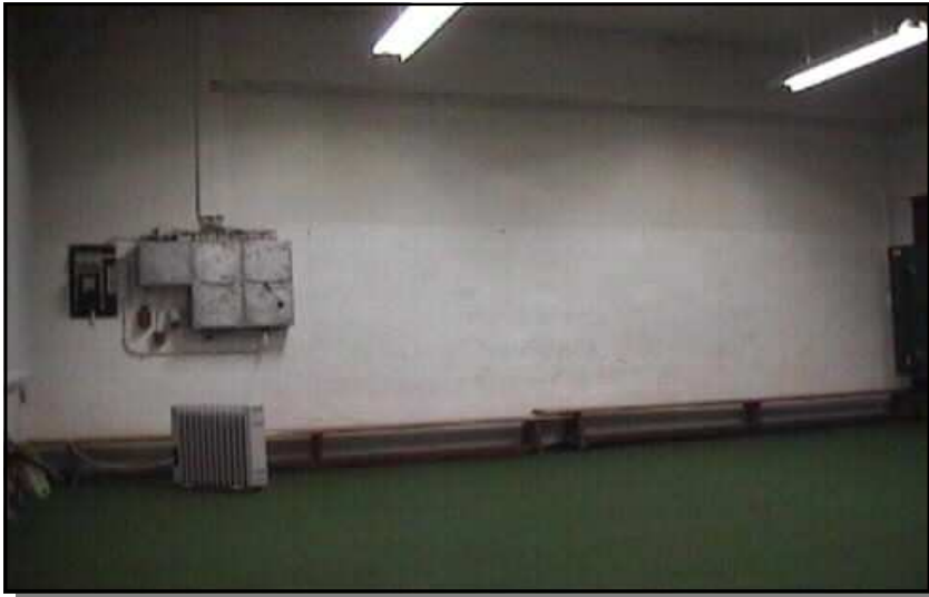
Innenansicht Turnhalle (Turnraum)
