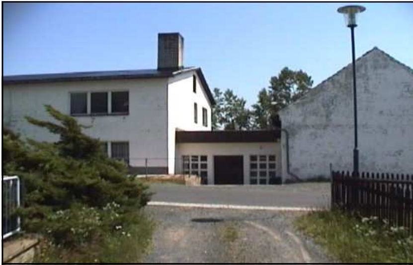
Ansicht Zwischenbau (Straßenseite)
