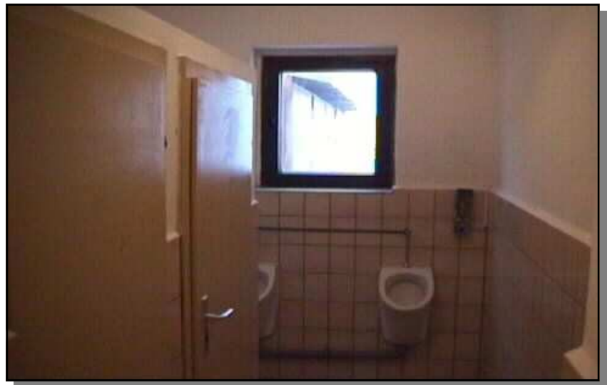
Zwischenbau (WC-Anlage Männer)
