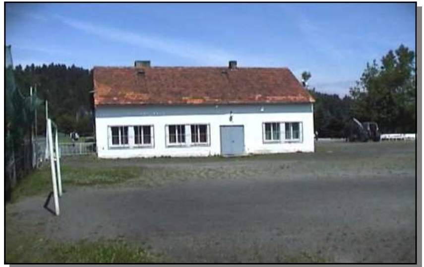
Ansicht Turnhalle (vom Sportplatz)
